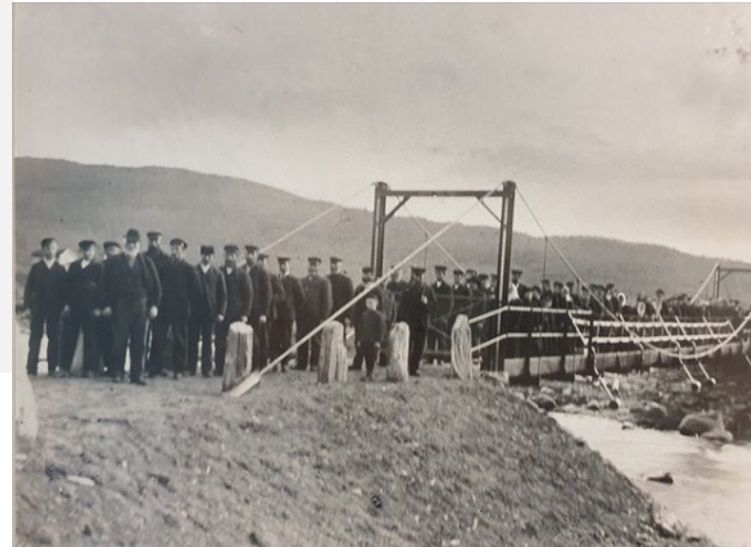
Prøvebelastning på første Sand bru i Malangen 1907.
