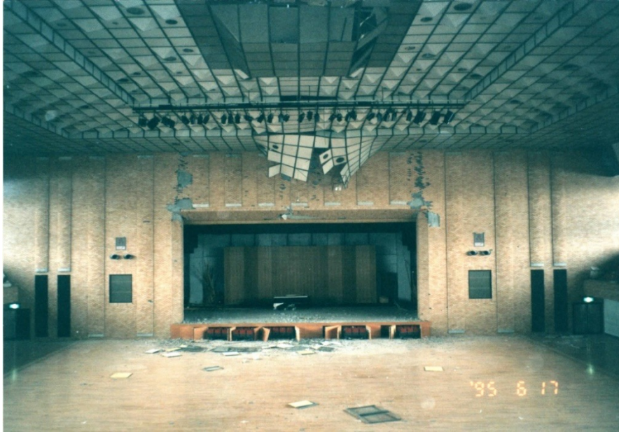
1995年1月17日 阪神・淡路大震災による天井落下事例
