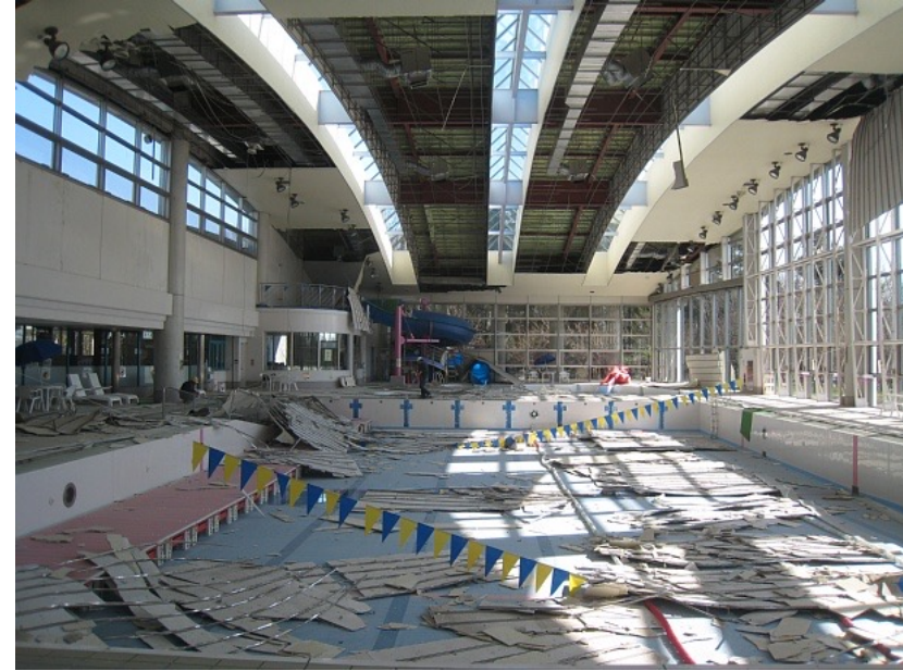
2011年3月11日 東日本大震災による天井落下被害
