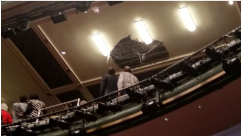
2019_11_06_ロンドンピカデリー劇場上演中の天井落下被害 BBC_News Japan より _109554299_hole
